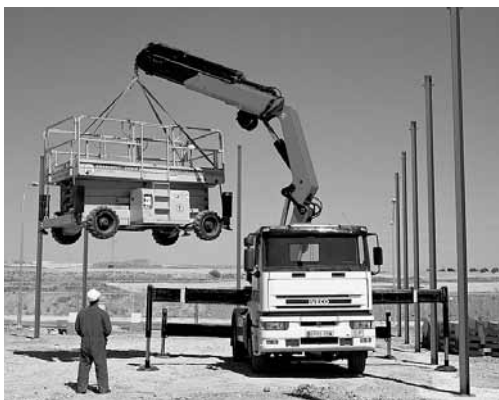
Illustration 6 (camion-grue): grue de camion avec un moment de charge de plus de 400 000 Nm ou dont la longueur de flèche est supérieure à 22 m.
