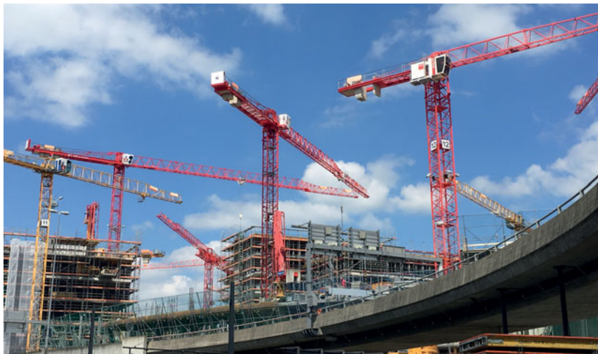
Circle-Baustelle: Kran-Invasion am Flughafen Zürich.
