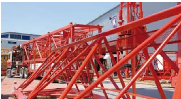
«Neue» Kranteile nach dem Sandstrahlen und Lackieren.
