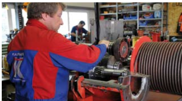
Instandsetzen eines Hubgetriebes.
