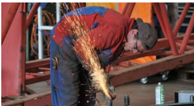
Instandsetzen und Verstärken des Stahlbaus nach Vorgabe des Statikers.
